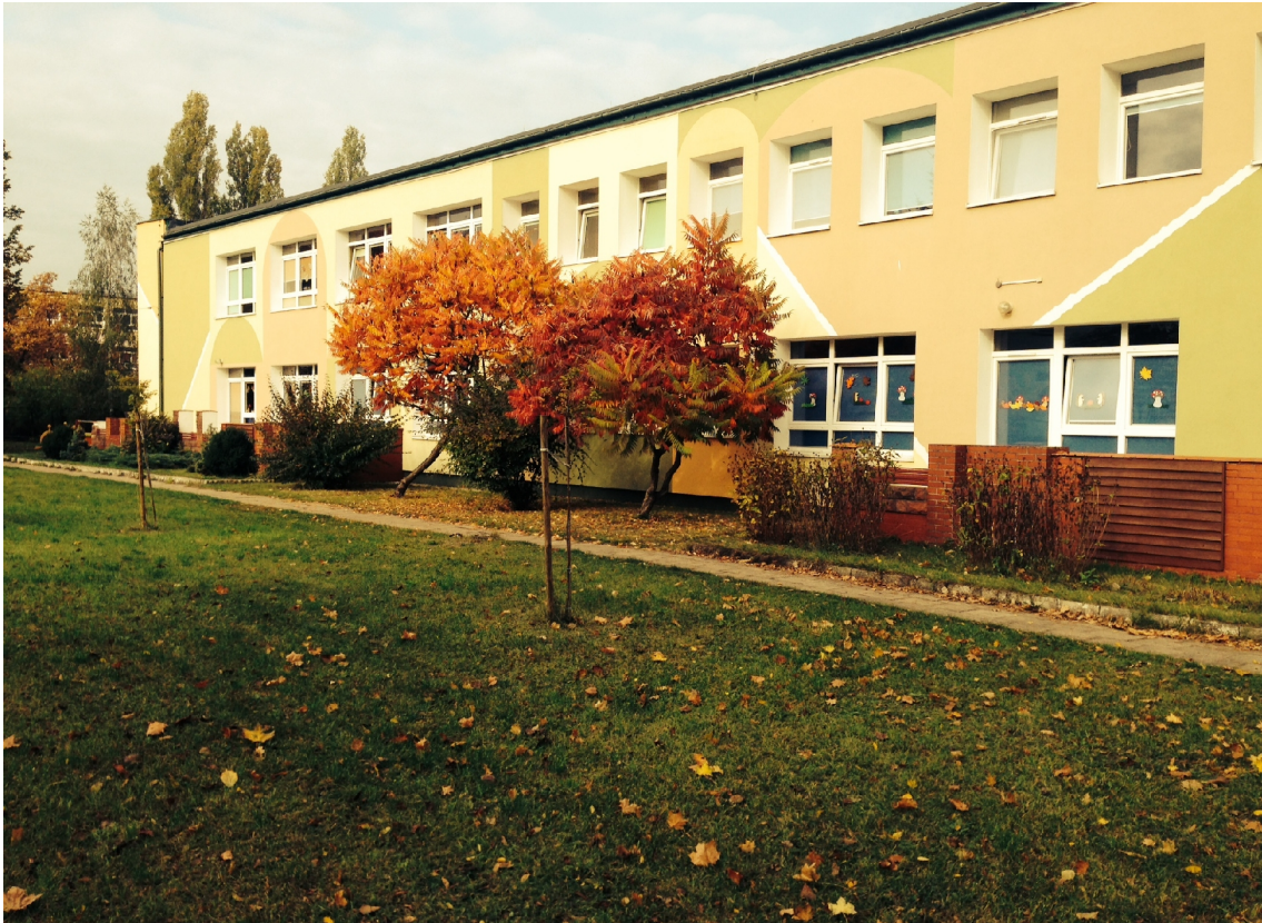
Zdjęcie 1: Tarasy i chodnik przy żłobku
